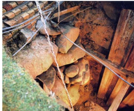
Dieses Foto der freigelegten Gründung entstand im Rahmen einer Bauwerksprüfung im Jahre 1991.
