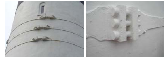
Die Zugbänder und die beiden Verschlusssysteme. Das obere ist 4x, das linke 3x vertreten.
