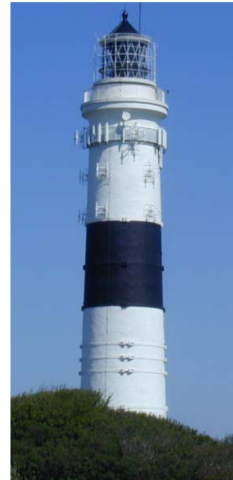
Rechts: Leuchtturm Kampen nach der Sanierung mit montierten AIS-Antennen, Mai 2006
