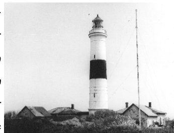
LF Kampen, rechts im Bild der Funkmast.
