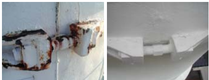
Oben: eingehauster Leuchtturm. Links: Zugband vor und nach Sanierung.
