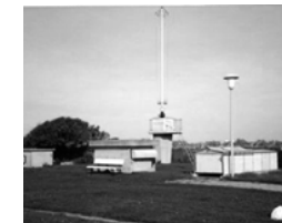
Der neue Funkmast auf seinem Betonsockel.
