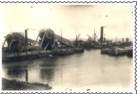
Bagger und Baumaschinen für den Hindenburgdamm im Amrumer Hafen, 1922/23.
