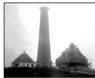
Bilder aus der Aufbauphase, hier: LF Westerhever
